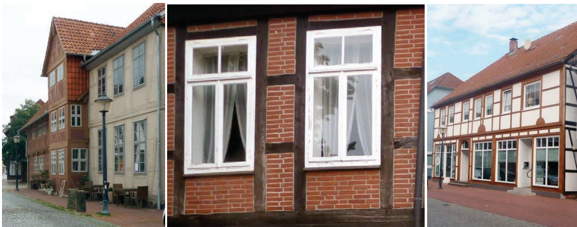
Foto 1: denkmalgerechte gut ausgeführte Fassadensanierung mit gegliederten Holzfenstern und verputzten Gefachen (Einzeldenkmal Lange Straße 59).
