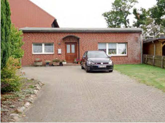
Abb. 5.4/1 Lindenstraße 9a: Bauliche Unternutzung des Grundstücks durch eingeschossige Bauweise
