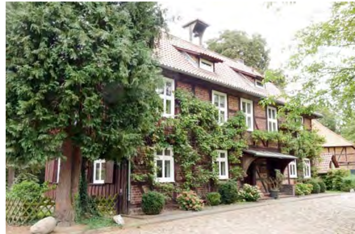
Abb. 1.2/1 Pforthaus von 1650 (bis 1859 das Amtsgericht)
