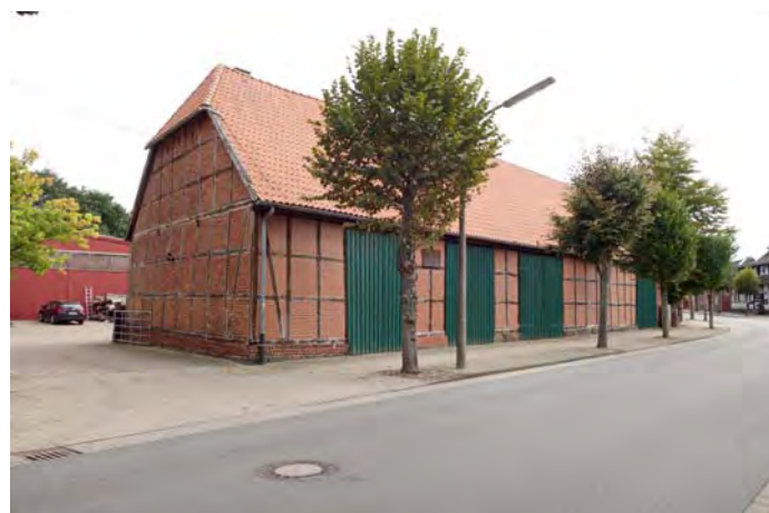
Abb. 2.7/6 Maschinenhalle von Lindenstraße 17
