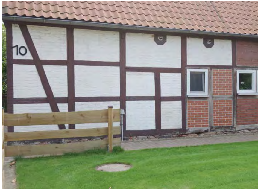
Abb. 5.2/1 Fachwerk von Lindenstraße 10, teilweise mit verschiedenen Ausbesserungen
